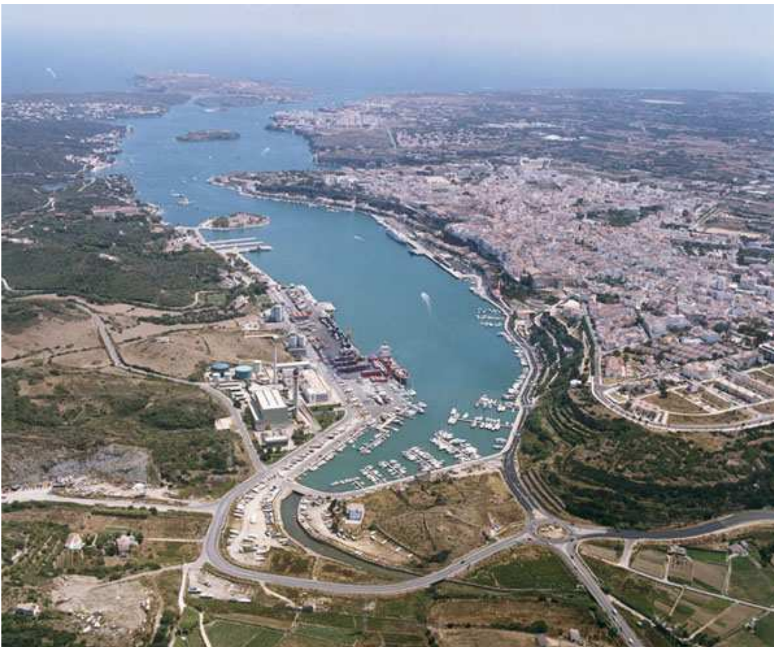
Vue aérienne du port de Mahon.
